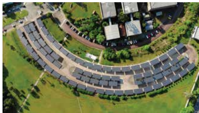
Figura 2 – Vista aérea da usina FV-BIO.
