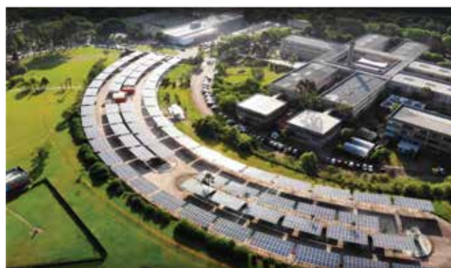
Figura 3 – Vista aérea 2 da usina FV-BIO.
